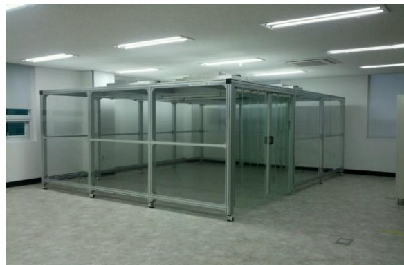
안양 H공장 클린부스 (Al 프로파일 + 폴리카보네이트벽)
