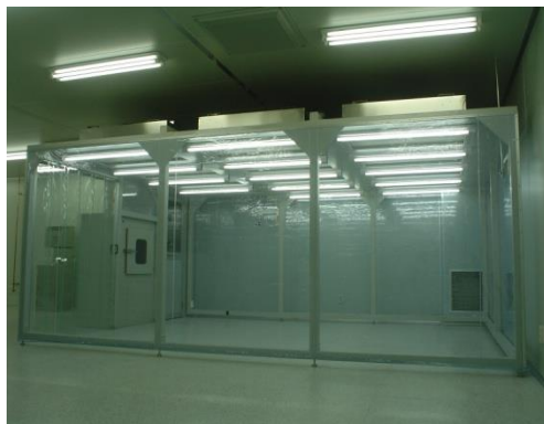
시화 C공장 클린부스 (스틸 + 무정전비닐벽)
